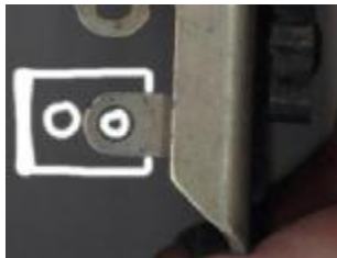
Der Lochstreifen wird in Blickrichtung zum Betrachter hin abgewinkelt angebracht
